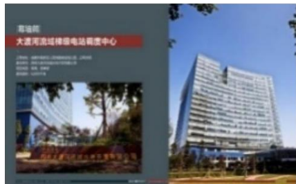
国电大渡河5G智慧水电站项目 西南首个在水电领域落地“5GAR”的项目
